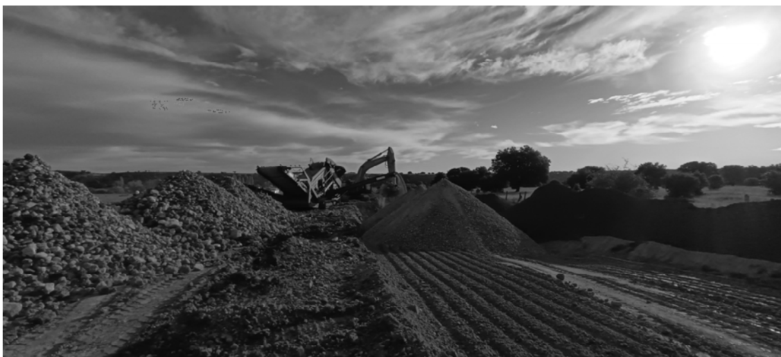
Figura 9. Detalle de los equipos para carga y cribado de materiales
